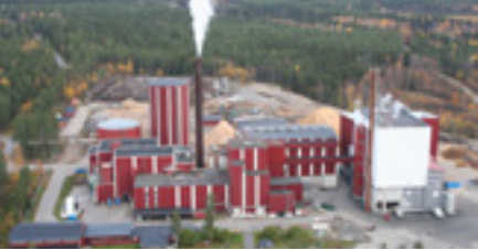
Bodens värmeverk (BEAB) som sedan i oktober 2010 slutbehandlar landstingets farliga avfall till värme för bodensarna.
